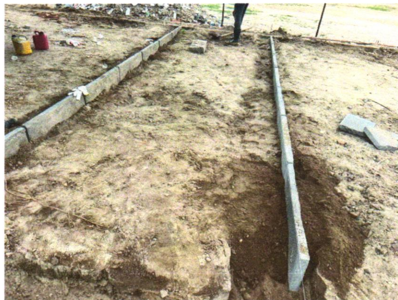
Foto 08 – ASSENTAMENTO DE GUIA (MEIO-FIO) EM TRECHO RETO, CONFECCIONADA EM CONCRETO PRÉ-FABRICADO, DIMENSÕES 80X08X08X25 CM (COMPRIMENTO X BASE INFERIOR X BASE SUPERIOR X ALTURA), PARA URBANIZAÇÃO INTERNA DE EMPREENDIMENTOS. AF_06/2016
