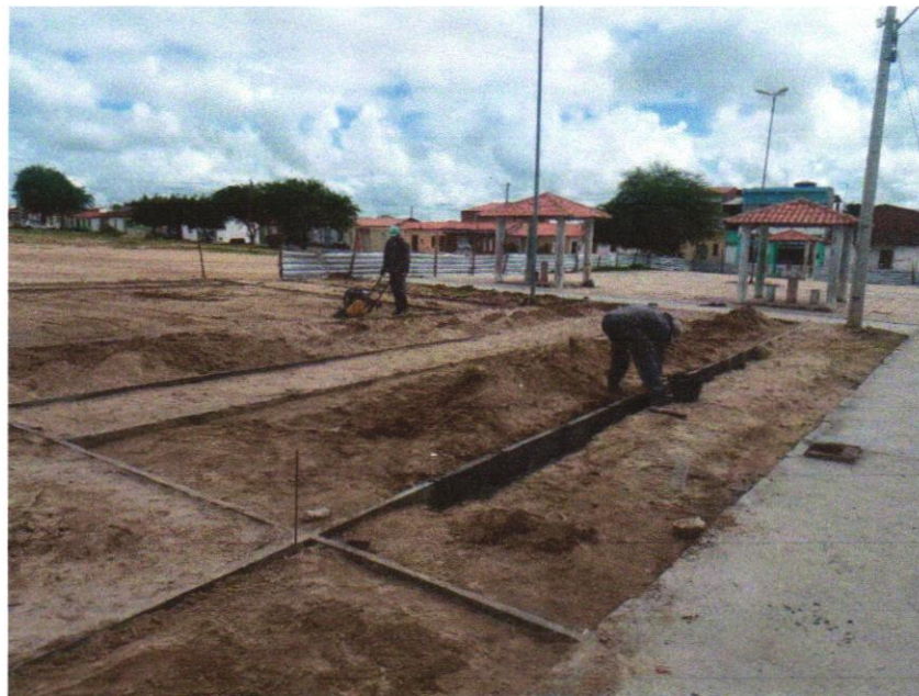
Foto 08 – ASSENTAMENTO DE GUIA (MEIO-FIO) EM TRECHO RETO, CONFECCIONADA EM CONCRETO PRÉ-FABRICADO, DIMENSÕES 80X08X08X25 CM (COMPRIMENTO X BASE INFERIOR X BASE SUPERIOR X ALTURA), PARA URBANIZAÇÃO INTERNA DE EMPREENDIMENTOS. AF_06/2016
