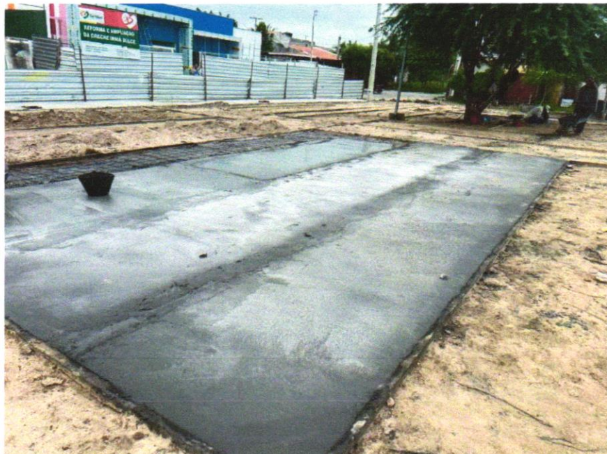
Foto 12 - PAVIMENTAÇÃO EM CONCRETO, COM ESPESURA DE 7 CM, COM ACABAMENTO FEITO UTILIZANDO ALISADORA DE CONCRETO (HELICOPTERO), INCLUIDO TELA DE AÇO SOLDADA NERVURADA CA60, Q196 (3,11 KG/M 2 ), DIÂMETRO DO FIO 5.0 MM, LARGURA = 2,45 M, ESPAÇAMENTO DA MALHA = 10 X 10 CM, JUNTA DE DILATAÇÃO EM PVC A CADA 2,00 M, CONCRETO FCK = 20 MPA
