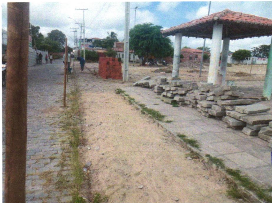
Foto 02 - RETIRADA DE MEIO-FIO DNER / ECONOMICO COM EMPILHAMENTO E SEM BOTA FORA
