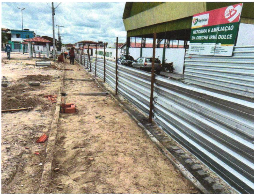
Foto 12 - PAVIMENTAÇÃO EM CONCRETO, COM ESPESURA DE 7 CM, COM ACABAMENTO FEITO UTILIZANDO ALISADORA DE CONCRETO (HELICOPTERO), INCLUIDO TELA DE AÇO SOLDADA NERVURADA CA60, Q196 (3,11 KG/M 2 ), DIÂMETRO DO FIO 5.0 MM, LARGURA = 2,45 M, ESPAÇAMENTO DA MALHA = 10 X 10 CM, JUNTA DE DILATAÇÃO EM PVC A CADA 2,00 M, CONCRETO FCK = 20 MPA
