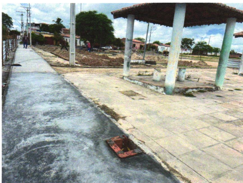
Foto 10 - CAIXA ENTERRADA ELÉTRICA RETANGULAR, EM ALVENARIA COM TIJOLOS CERÂMICOS MACIÇOS, FUNDO COM BRITA, DIMENSÕES INTERNAS: 0,3X0,3X0,3 M. AF_12/2020
